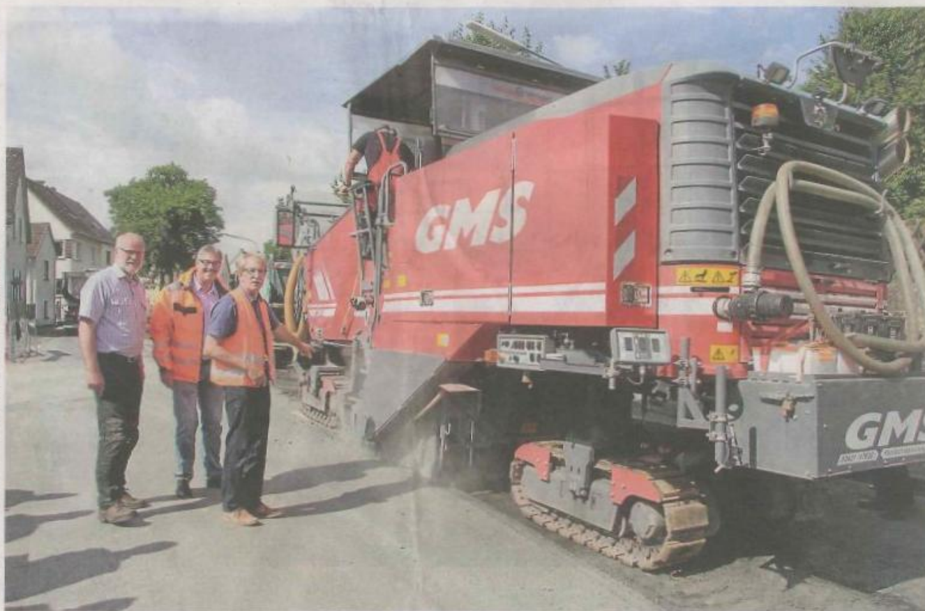
Seit Montagmorgen wird die Fahrbahn der Gießener Straße im ersten Bauabschnitt abgefräst. 50 Zentimeter tief wird die alte Straße abgetragen, anschließend mit Schotter, Tragschicht und Asphaltdecke in derselben Höhe wieder aufgebaut (v. l.): Bürgermeister Eckhard Schultz, Bauamtsleiter Klaus Scharmann und HessenMobil-Chef Eugen Reichwein. (Foto: Gross)
